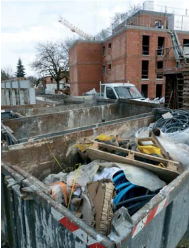
Benne Suez de captation de déchets d'un chantier de construction d'un petit collectif à Saint-Jean-d'Illac, Gironde.
