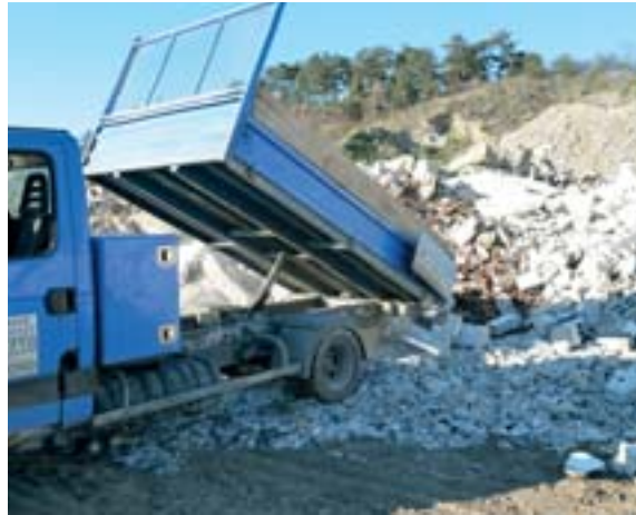
Artisan maçon en train de vider des déchets de démolition d'un petit chantier sur le site Michel à Venoy, Yonne.
