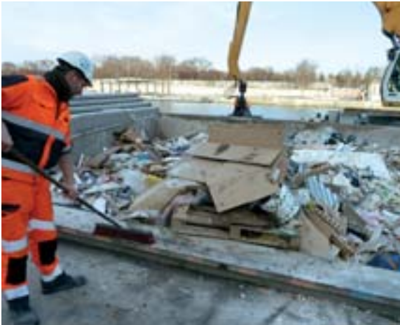
Nettoyage du talon en bordure de quai le long d'une barge en cours de remplissage, sur le port Cemex de Tolbiac, Paris XIII e .
